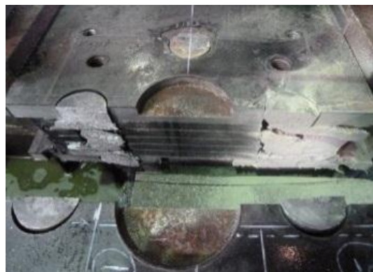
写真-5 支承外面（上）及び内部状況（下）
