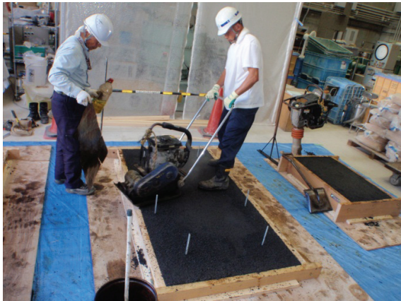
a) 舗装の転圧時
