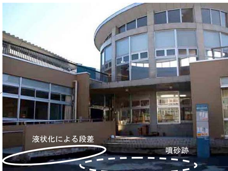
写真-1 地点1の液状化被害状況 ③に加筆
