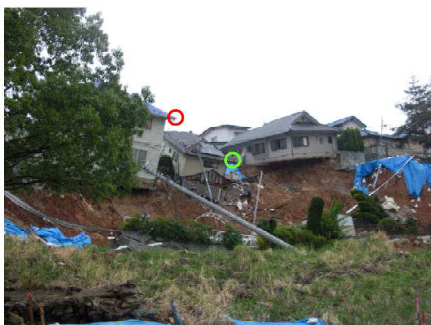
写真-3 福島市伏拝の宅地造成盛土の被災状況(1)
