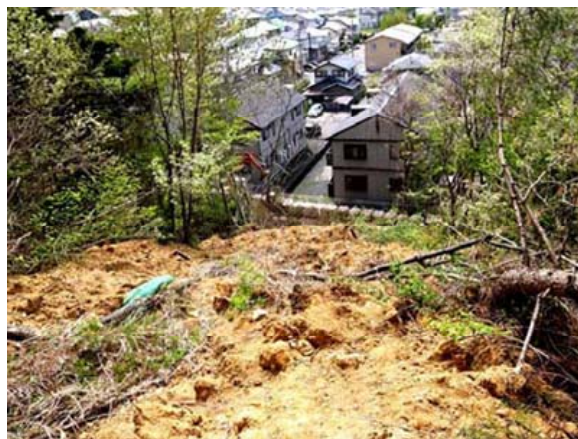
写真-2 地すべり末端部の住宅地に迫る流出土砂 3)4)
