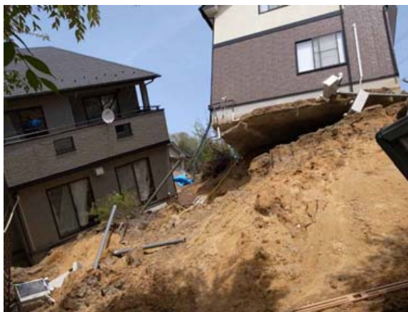
写真-1 地すべり頭部の崩落崖下方からの被災状況 3)4)
