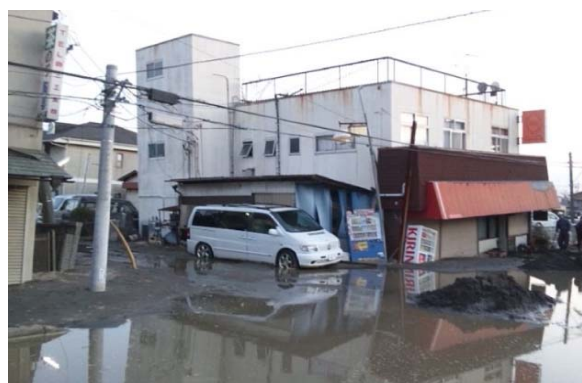
(b) 建物のめり込み沈下
