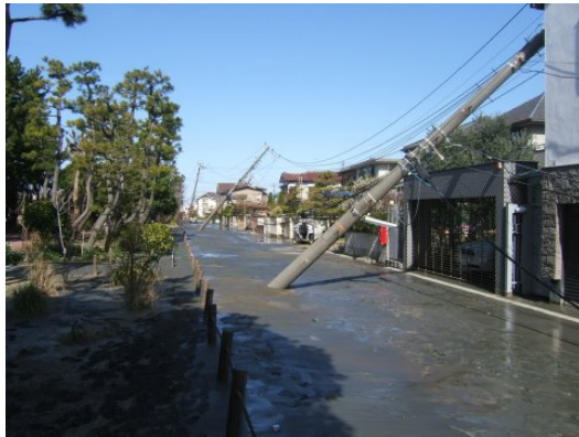
(b)噴砂・電柱の傾動状況
