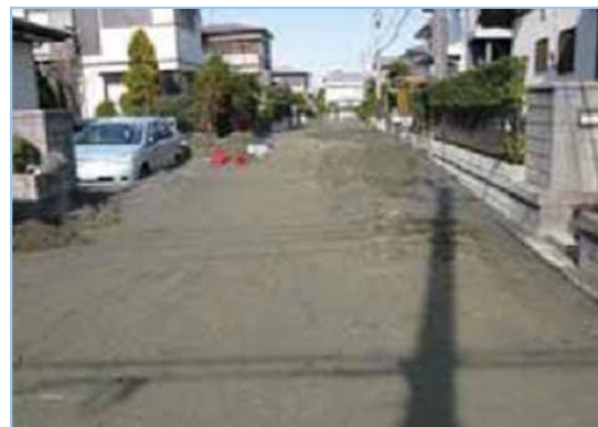
(a)道路の噴砂状況
