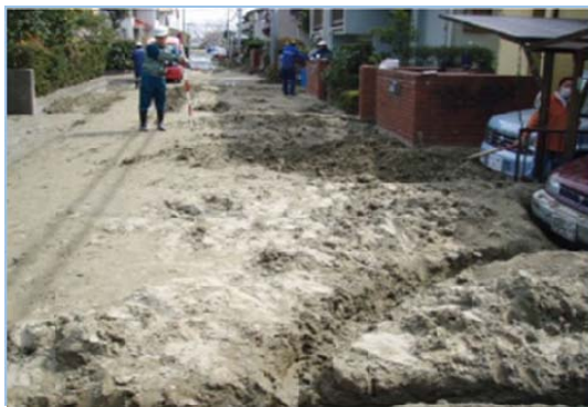
(b)宅地のめり込み沈下状況
