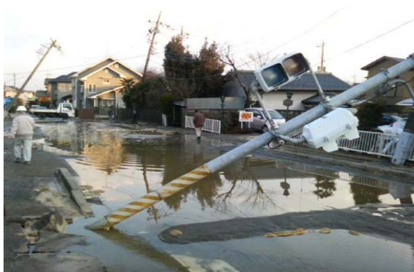
(a) 幹線道路の沈下
