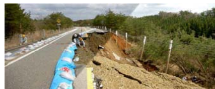
写真-2 39-1 地点の被害盛土：石川県による
