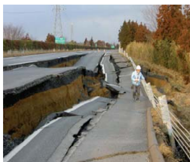
写真-1 常磐自動車道の被害盛土：NEXCO 東日本株による
