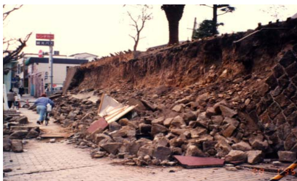
写真1 擁壁被害
