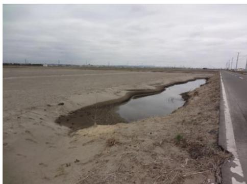
写真-21 農道の背後の落堀：左後方の白い帯が調査箇所
