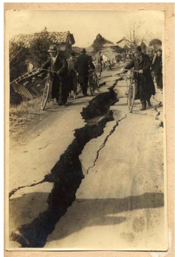
図-3 江ノ口川堤防の被害（高知市所蔵）
