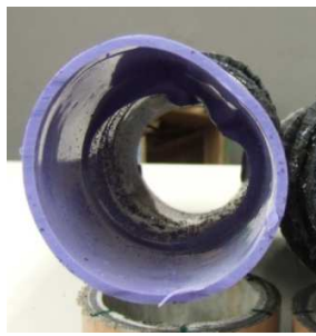
写真-7 ライニング管の状況
