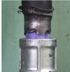
写真-9 屈曲ライニング管状況
