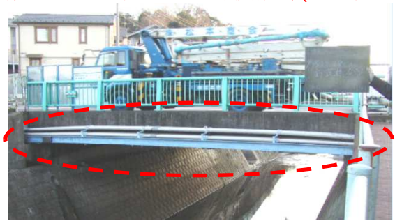
写真-10 通信専用橋設置状況
