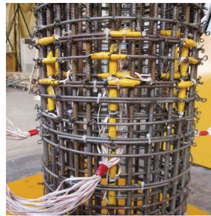
写真-9 ひずみゲージ貼付の様子
