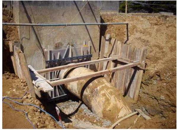
写真-2 急速混和池流出管の漏水 (堀口浄水場) ⑥
