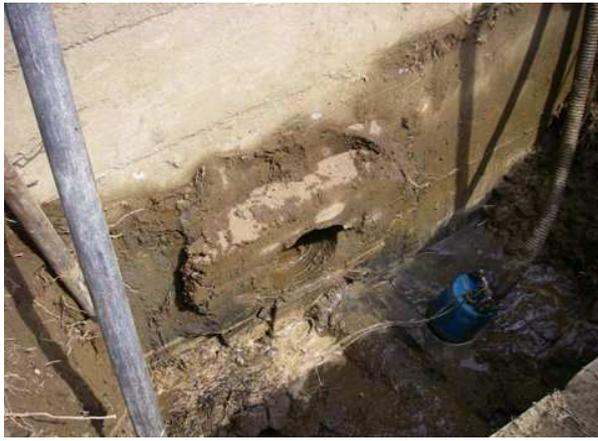
写真-1 浄水池越流管の管体損傷 (虻田浄水場) ⑥
