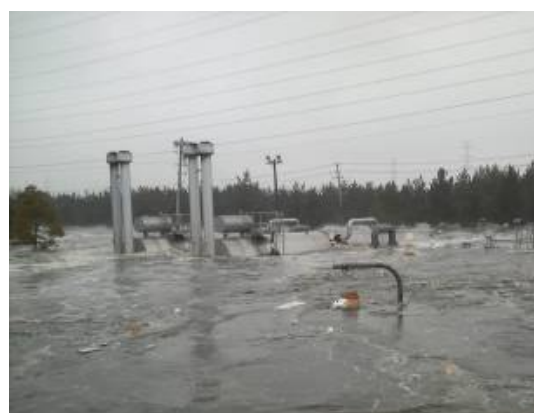
図-2 津波により浸水する受渡し施設
