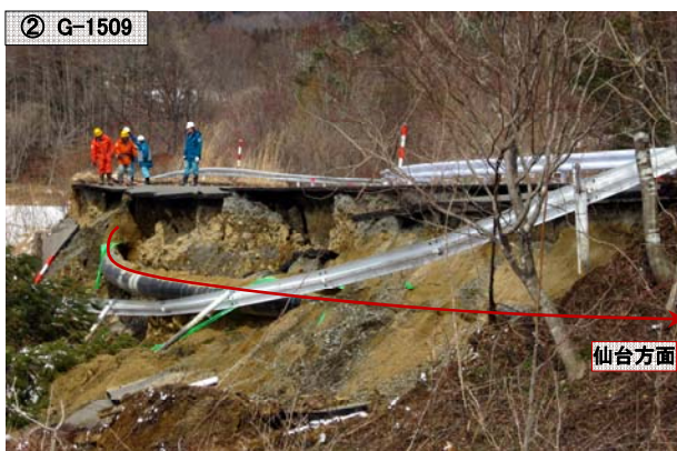
図-4 山間部での道路崩壊とパイプラインの露出
