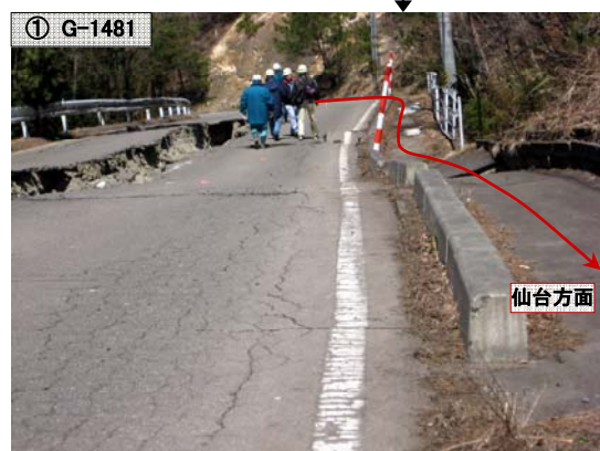
図-4 山間部での道路崩壊とパイプラインの露出
