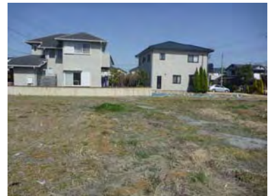
写真-24 噴砂と塀, 民家の沈下
