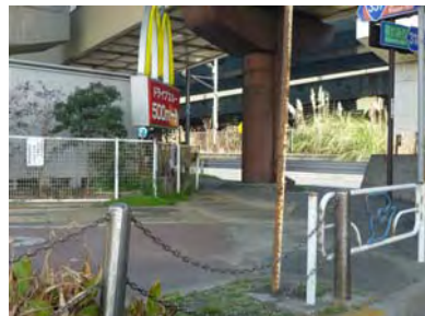
写真-8 臨海公園付近の液状化
