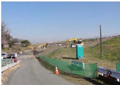
写真-16 河川堤防斜面の流動
