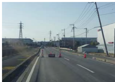
写真-26 道路の沈下 亀裂 段差
