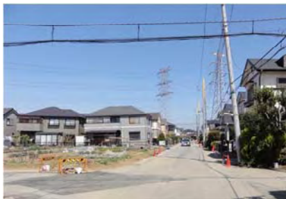
写真-22 住宅, 電信柱の傾斜, 道路沈下
