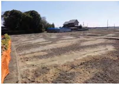
写真-19 農地の亀裂・流動・ 大量の噴砂
