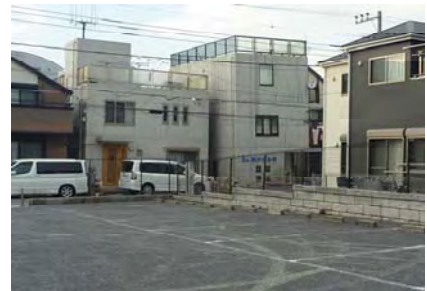
写真-12 戸建住宅の傾斜
