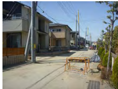
写真-23 すべての電柱が傾斜
