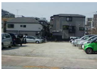
写真-7 戸建住宅の沈下・傾斜
