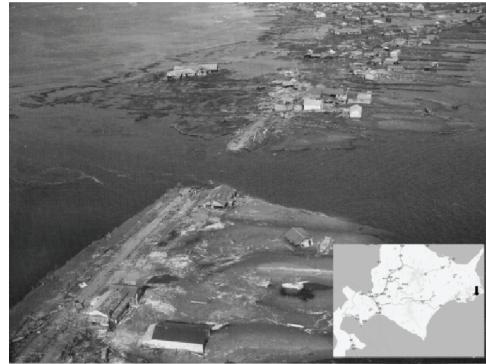
図-2 1960年チリ津波による盛土堤防の決壊の様子（北海道厚岸郡浜中町）
