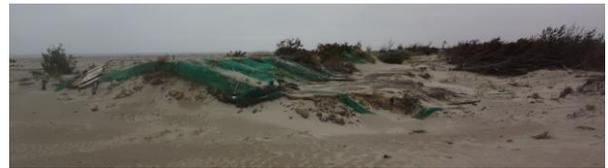
写真-14 侵食, 破堤した低盛土と落堀 9/11 : 関上南
