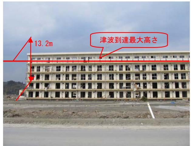
図-10 雇用促進住宅の浸水状況
