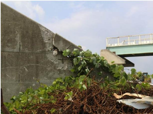
写真-2 A1 袖擁壁の断面欠損と傾斜
