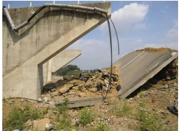
写真-3 A2 背面の盛土流失状況
