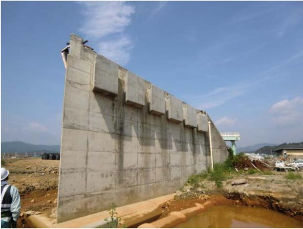
写真-4 A1橋台基礎部の洗掘状況
