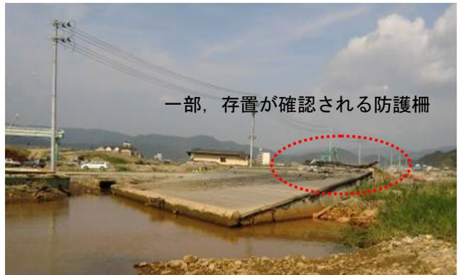
写真-1 第3径間流失上部構造
