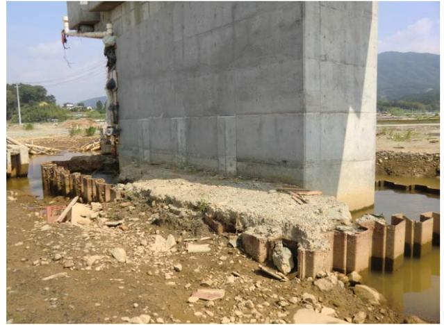
写真-5 P1橋脚基礎部の洗掘状況
