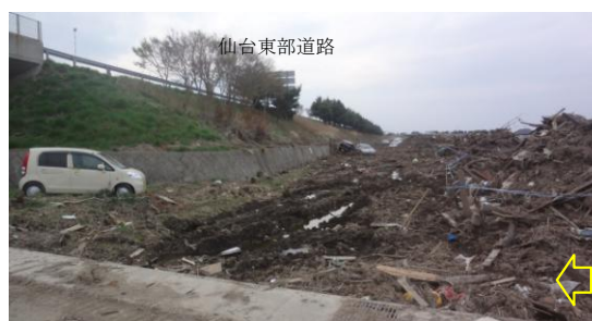
写真-13 仙台東部道路盛土の海側の状況 430: 事例 3
