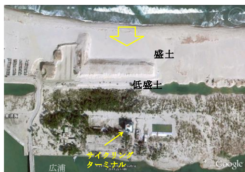
写真-14 浜辺に置かれた盛土：津波後4/6：事例4
