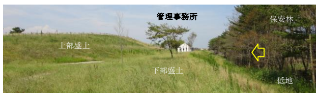
写真-32 高台の海側の状況9/12：事例9
