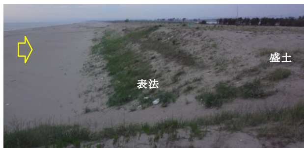
写真-16 盛土の表法 7/9：事例4
