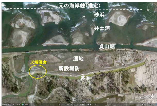
写真-1 井土浦の新設堤防 4/6：事例1
