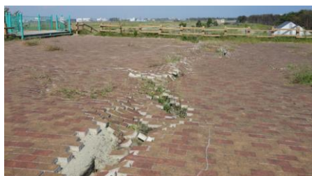
写真-33 高台の頂部の広場のクラック9/12：事例9
