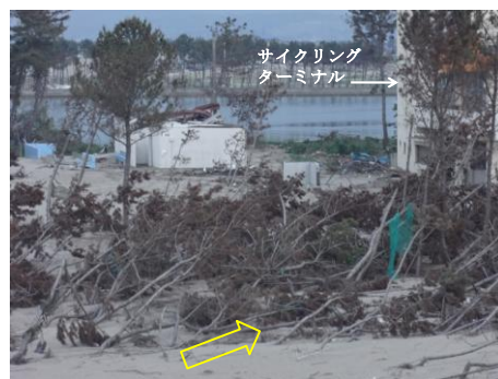
写真-19 盛土の南端からの回り込みの様子 7/9：事例4
