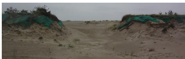
写真-22 盛土全体が侵食，流出 9/11：事例5
