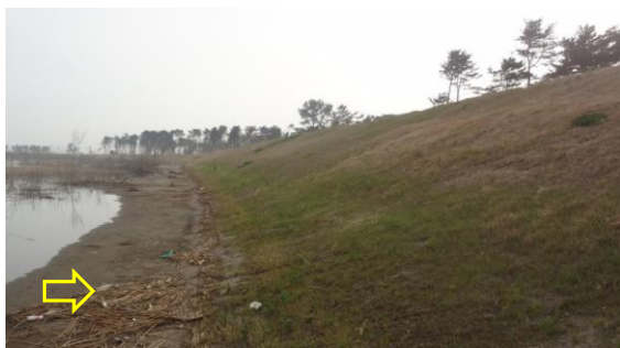
写真-2 津波後の新設堤防の表法 4/30：事例1
