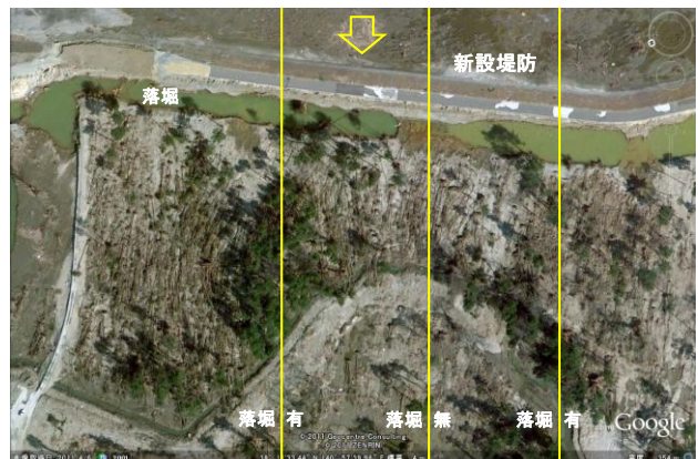
写真-6 堤防の裏法側の落堀の形成の有無と保安林 4/6：事例1
