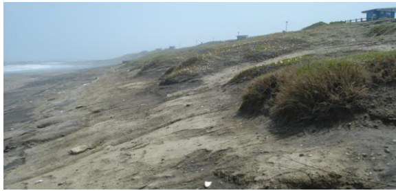
写真-51 斜面下部の侵食跡
