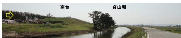
写真-31 貞山堀に隣接する高台9/12：事例9
