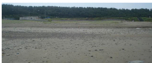
写真-49 緩勾配の斜面の遡上位置 : 左奥トイレ付近 : B地点
