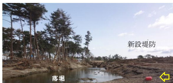
写真-10 津波後の裏法と落堀 430: 事例 2
