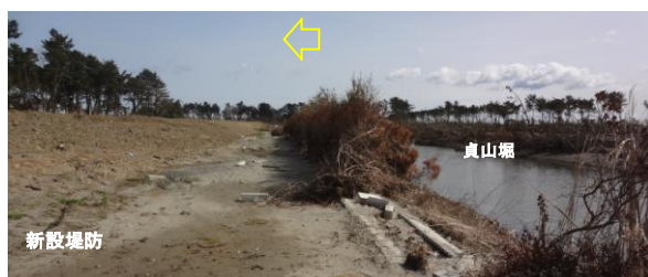
写真-9 津波後の表法の状況 430: 事例 2
