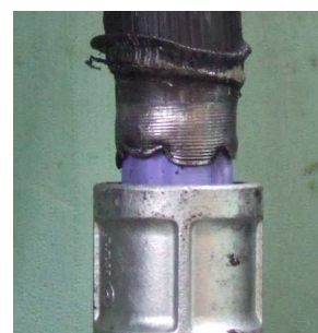
写真-4 屈曲ライニング管の状況
