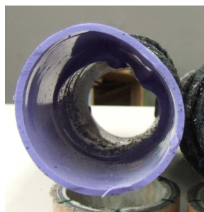
写真-2 ライニング管の状況
