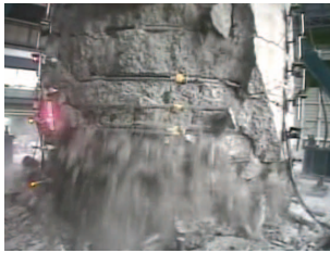
写真-1 コアコンクリートの破壊状況
