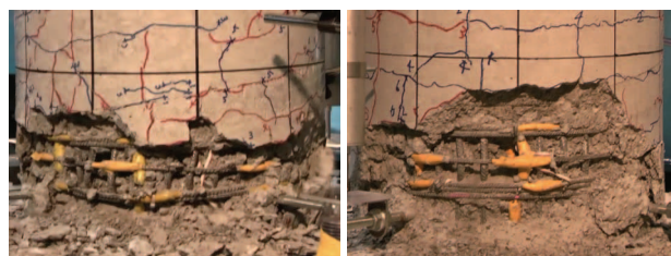
(a) S-1模型 (b) S-2模型 写真-10 SW面における最大変位発生時の損傷状況 (7回目加震)
