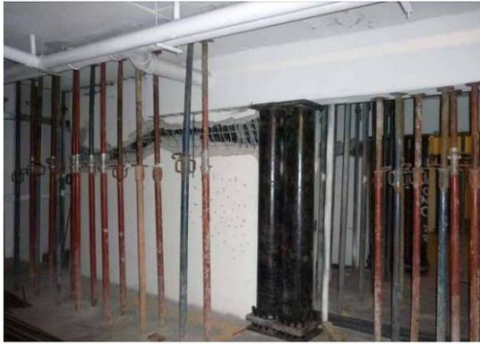
図-17 高層マンション地下耐力壁の水平方向亀裂<sup>12)</sup>
