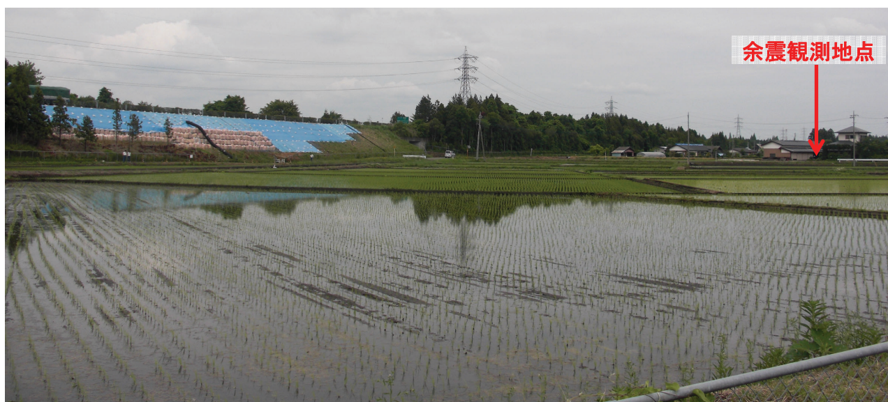
写真-2 被災盛土と余震観測地点
