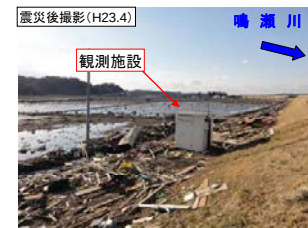
写真-1 観測施設状況
