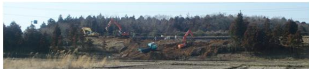
写真-2 復旧の状況 (3/13)
