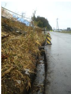
写真-3 法先の状況 (4/6)
