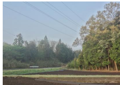
写真-10 下り車線側の盛土 (左側) と法先の状況 (4/30)
