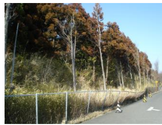
写真-6 法先の状況 (3/13)
