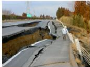
写真-1 被害状況
