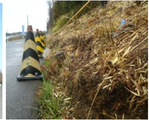
写真-7 法先の状況 (4/9)
