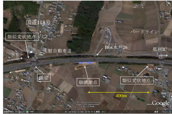
写真-5 被害盛土の周囲の状況：4) に加筆
