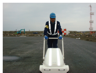
写真-2 探査の様子
