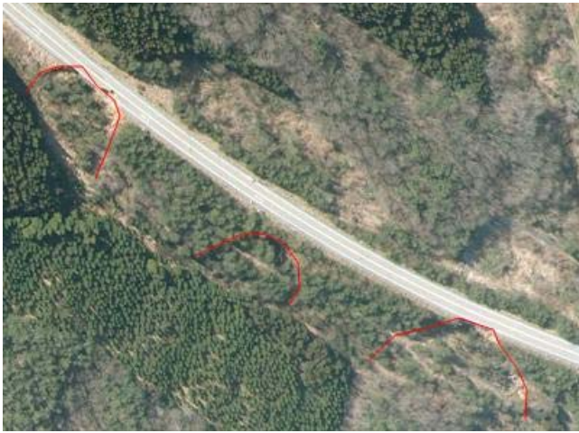
写真-6 縦-39 の盛土崩壊状況 4)
