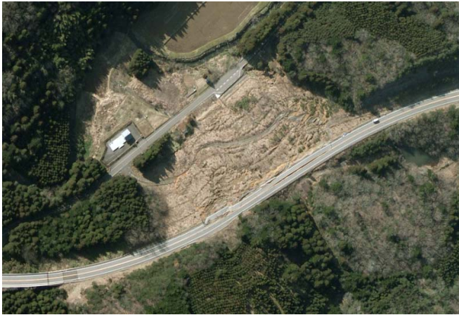
写真-5 縦-9 の盛土崩壊状況 4)
