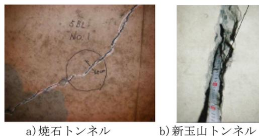
写真-3 焼石・新玉山トンネルの覆工に生じたひび割れ
