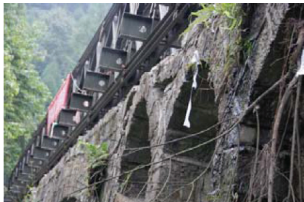
写真-16 アーチクラウン部と1/4との中間部に生じた損傷
