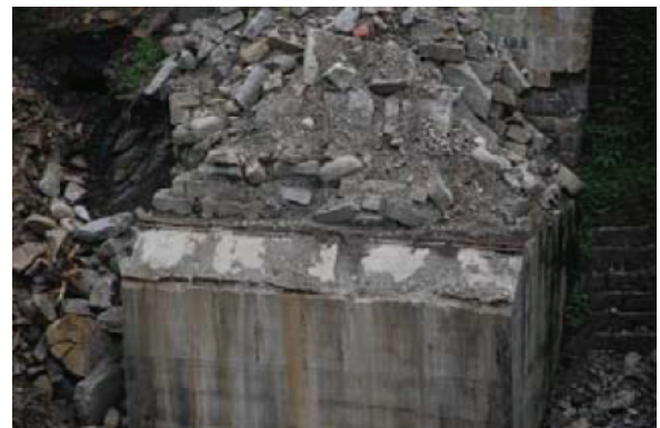
写真-14 アーチ主構の支持部
