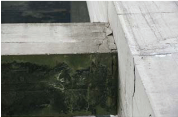
写真-2 鉛直材と横梁との接合部のクラック
