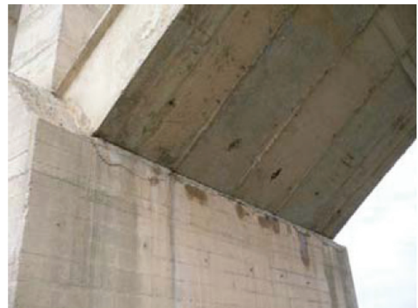
写真-10 アーチリブの付け根のひび割れ
