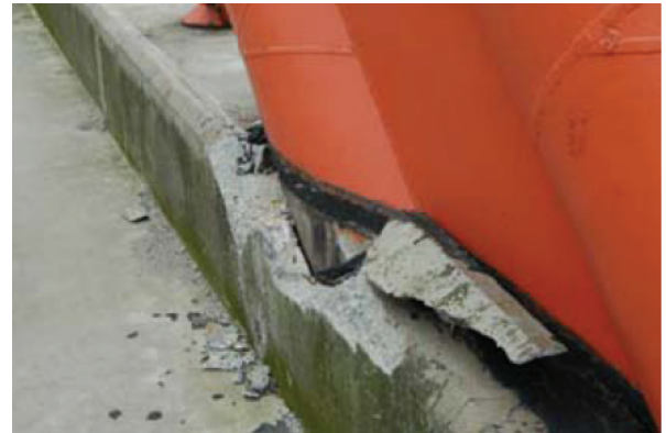
写真-20 パイプアーチ位置における縁石の損傷
