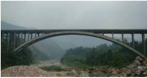
写真-1 金花大橋
