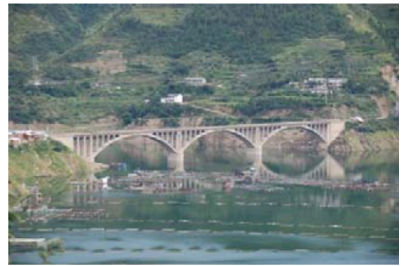
写真-9 白水大橋
