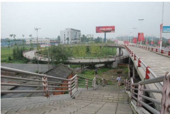
写真-11 ランプA全景
