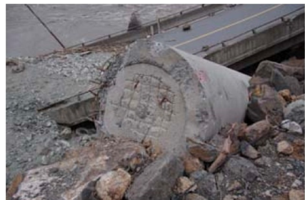
写真-4 ゴム支承が設置されていた橋脚柱上端
