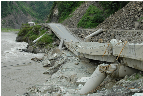
写真-5 爆破により倒壊した区間
