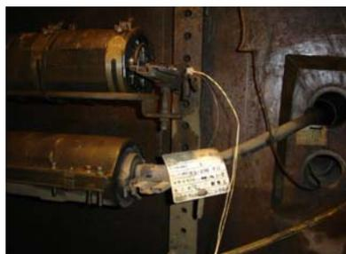
写真-1 マンホール内での光ケーブル切断
