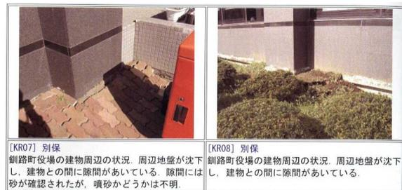
図-4 釧路町役場の被害写真<sup>12)</sup>
