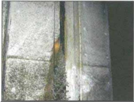
(b) 水処理施設のずれからの漏水（堀之内浄化センター）
