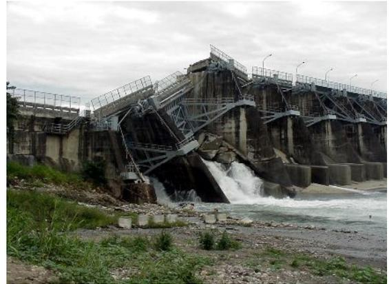
破壊である。大きな変位を持つ地表断層が、施設直下に現われた場合には、『無駄な抵抗はやめよ』とされているようである。しかし、このような大きな地表断層が、過去に断層の痕跡もないところに現われた例はないといってもよいので、そのようなところに、重要な施設を作らないことによって防止できる。
