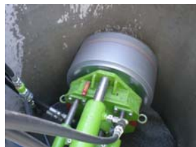
写真-8.2 開口状況
