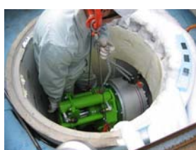
写真-8.1 カッター設置
