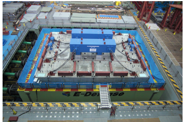
図-12 実機模擬試験体の設置状況
