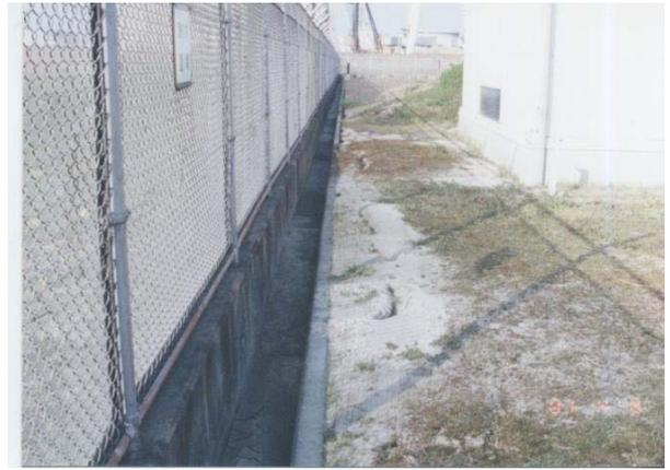
写真-1 調査地点（壬生川の埋立地）における2001年芸予地震の際の液状化噴砂の様子
