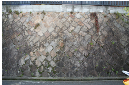
写真 3 西片山地区の無被害の石積み擁壁
