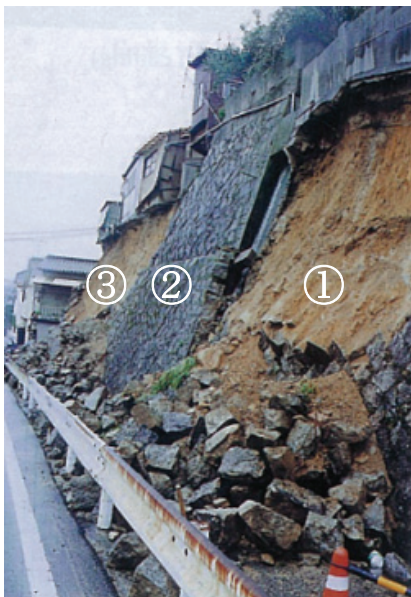
写真 1 宮原地区の石積み擁壁 9)
