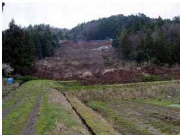
写真-1 崩壊後の対象谷埋め盛土斜面
