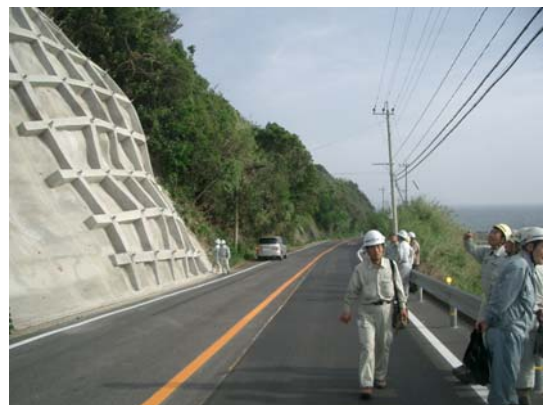
写真一2 復旧された弘地区の崩壊斜面、道路
