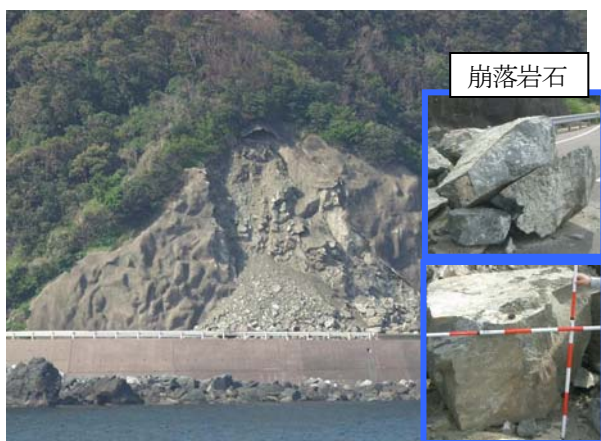
写真一3 黒瀬地区崩落斜面状況
