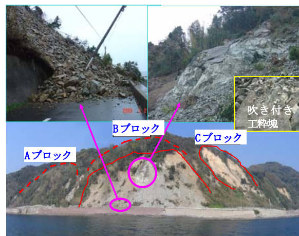
写真一4 志賀海神社北地区の崩落斜面状況
