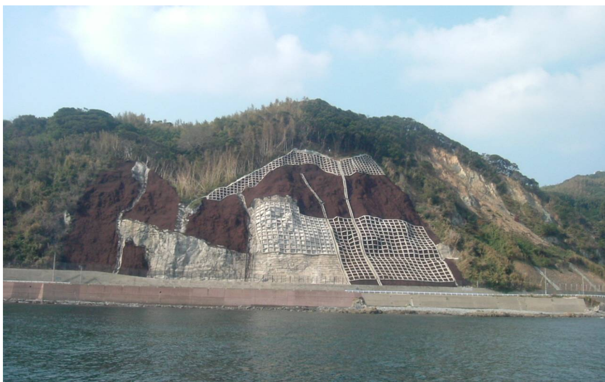
写真—8 志賀海神社北地区の崩壊斜面の復旧後の様子
