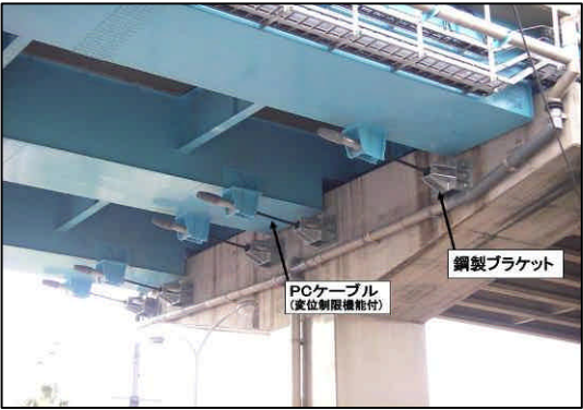
写真-9 耐震補強された都市高速道路の橋梁
