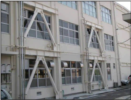
写真-8 耐震補強された校舎
