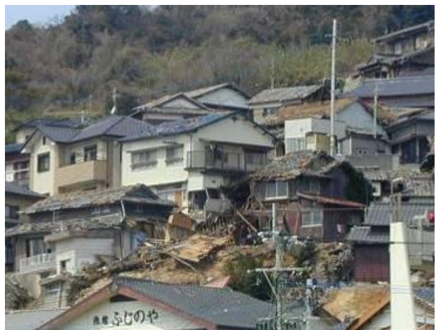
写真 2 被災直後の状況（近景）
