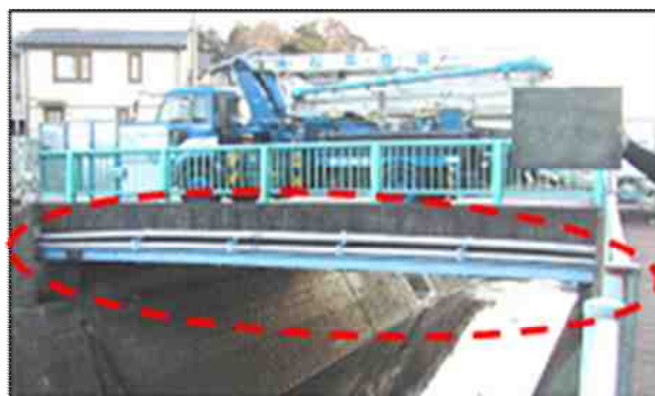
図-1 専用橋設置状況
