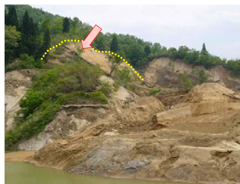
写真-1 東竹沢地点の地すべり滑落崖 (矢印は砂岩 A の採取地点)
