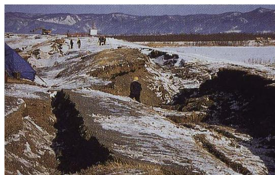
図-2 1993年釧路沖地震における十勝川統内地区築堤の被災状況
