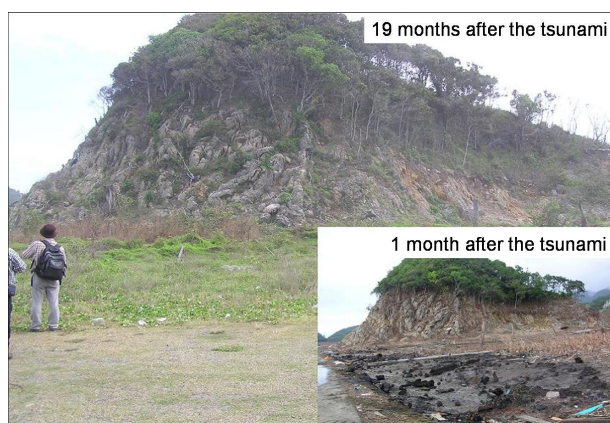
写真-1 Leupungの津波痕跡
