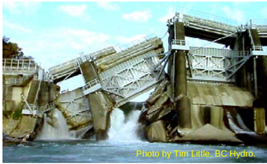
図-1 台湾収集地震での石岡ダム地震被害事例 1)
