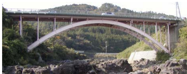
写真-1 対象橋梁の全景
