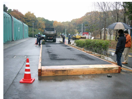
写真-1 模擬段差（段差量20cmの場合）
