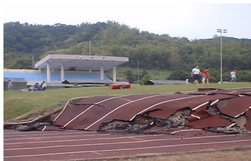
写真-1 集集地震の地表地震断層
