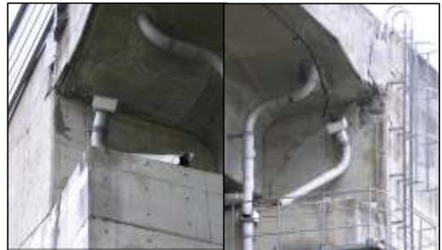
写真-1 A1橋台損傷状況
